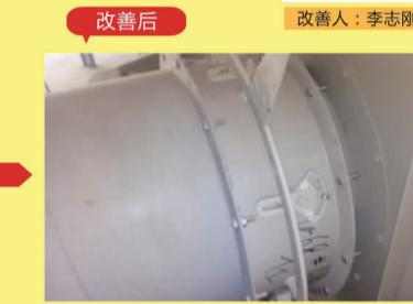
现我司风管设计采用法兰连接的主要出口项目，而出口项目风管连接的设计没有特殊要求。导致现在我司出口项目的风管连接，不够美观。
