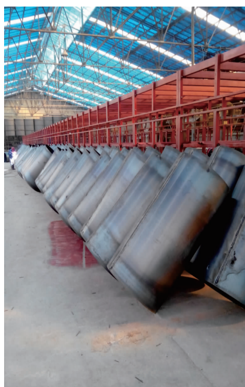
SD180 项目施工现场
