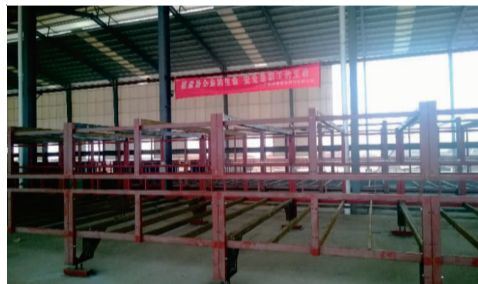
JX245 项目施工现场
