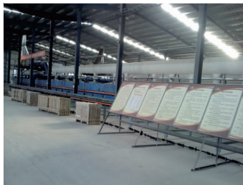
SX17 项目施工现场
