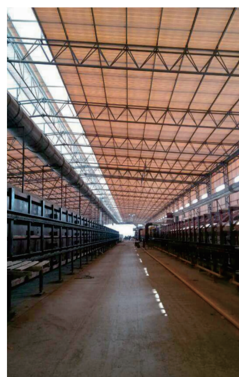
GSZ05 项目施工现场
