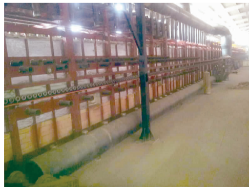
XJ07 项目施工现场
