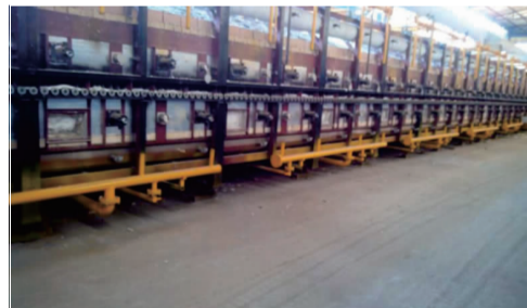
SX20 项目施工现场
